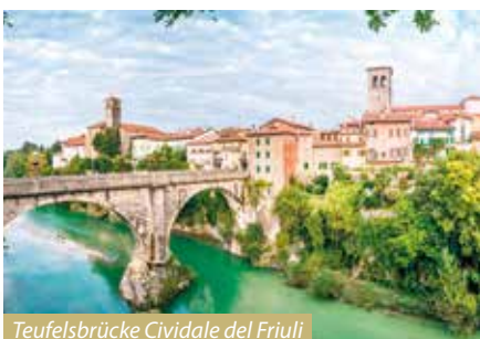
Teufelsbrücke Cividale del Friuli
